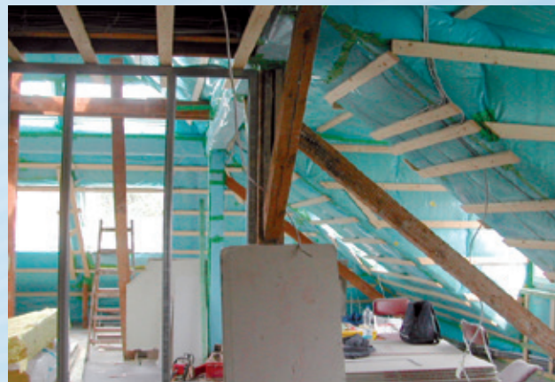
BlowerDoor měření pro zjištění kvality prací v průběhu výstavby
