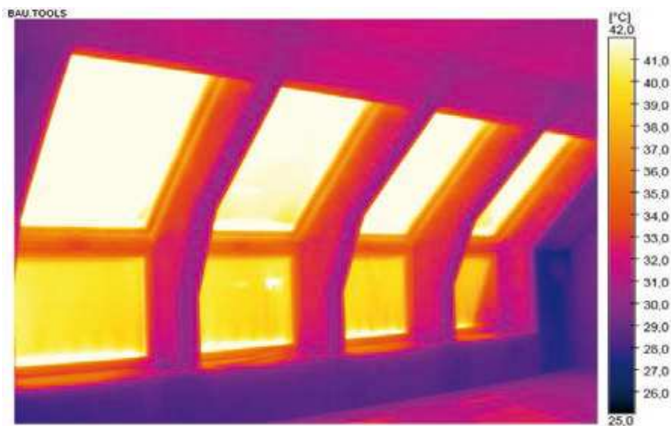
Termogram při vytvořeném podtlaku
