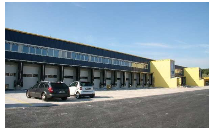
Logistická hala : 40 000 m 3
